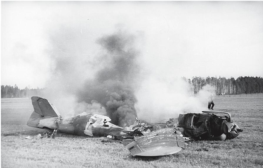
Abb. 6 Brand einer bruchgelandeten Bf 109 des JG 53. Eine Zerstörung des Flugzeugs durch eine Tankexplosion ist nicht zu erkennen, wohl hat brennendes Benzin das Aluminium des Rumpfs zum Schmelzen gebracht. Der schwarze Rauch entstand durch den Brand des gummibeschichteten Tanks. (Quelle: Sammlung Peter Petrick).
